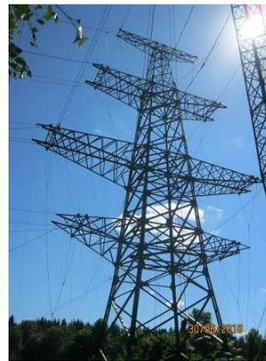
Одностоечные двухцепные анкерно-угловые и промежуточные опоры для линий электропередачи 500 кВ.
