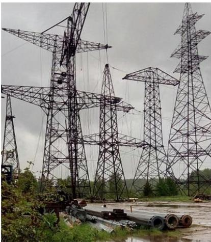
С 2016 года по заказу ФСК ЕЭС ведётся разработка новых унифицированных стальных решётчатых опор ВЛ 220-500 кВ и железобетонных фундаментов опор ВЛ 220-500 кВ по ПУЭ-7.
